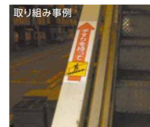
〈住江テクノ(株)奈良工場〉階段の手すりに注意喚起ステッカーを貼付
